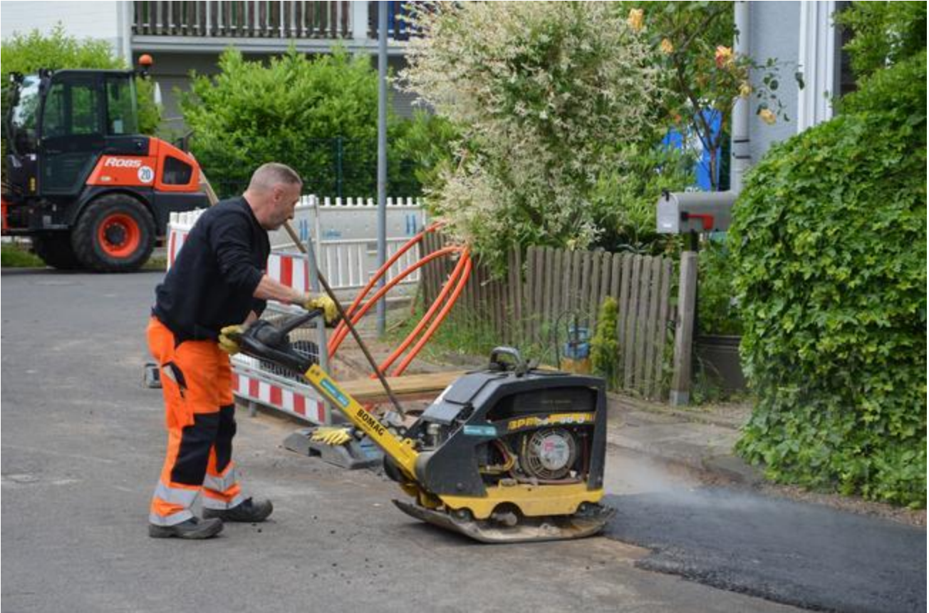
Die Arbeiten zum Glasfaser-Ausbau in Bornheim haben begonnen
